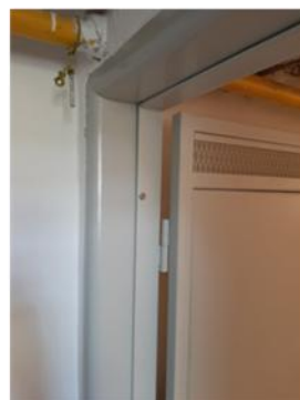
detail umístění do původní zárubně
